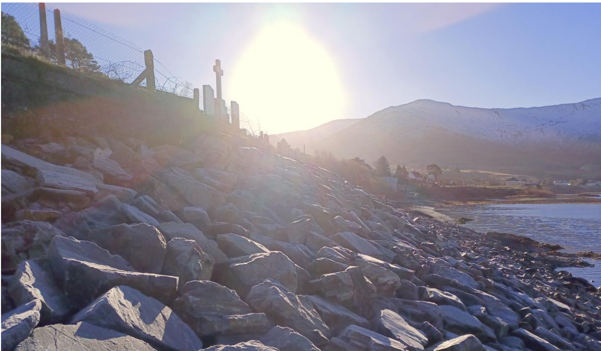
Oibreacha Cosanta Cósta críochnaithe i Reilig an Líonáin 2022
