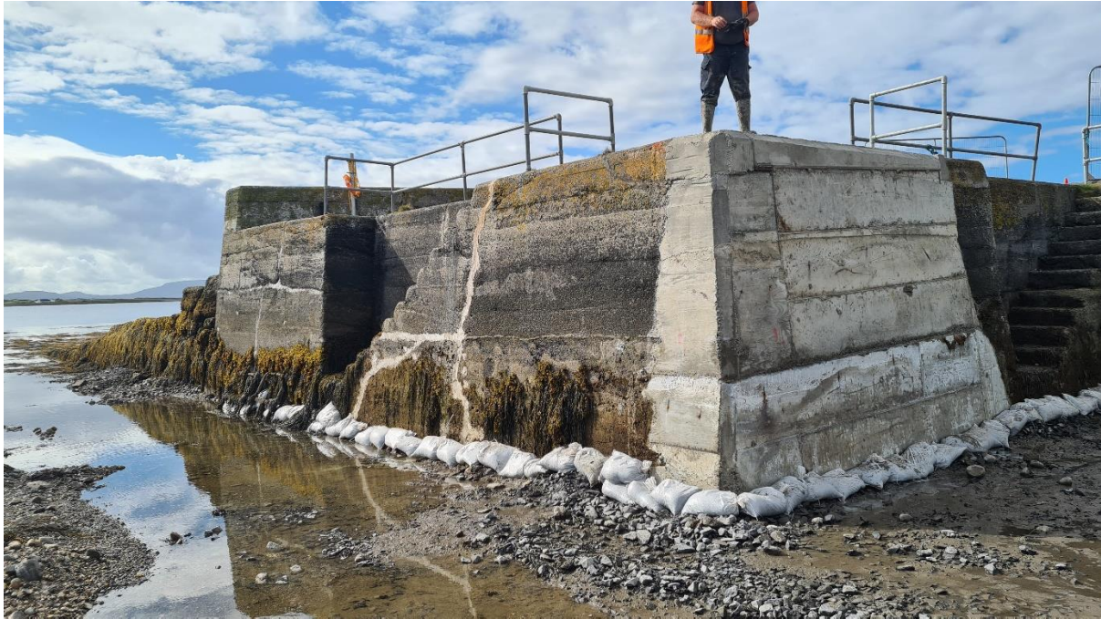
Oibreacha Críochnaithe ag Cé na Cora Duibhe (Blackweir) - Tionscadal maoinithe ag BALAMI
